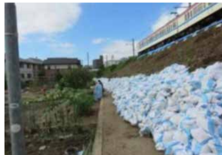
大型機械の進入できない鉄道敷法面の保護
