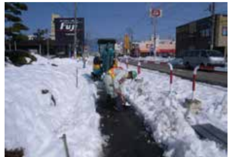
小型重機による通学路の除雪
