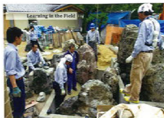
滝石組み作業風景 ベテランと若手がセンスを共有
