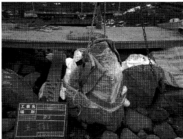
写真-5 脆弱部を養生し、胴巻きをした景石
