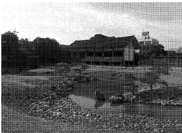
写真－2 整備後の全景写真(北東から)
