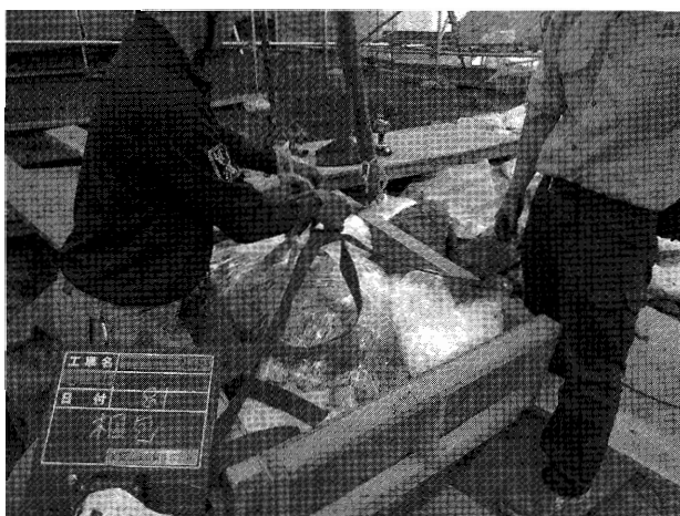
写真-9 養生した景石を箱ごと玉掛けして移動する
