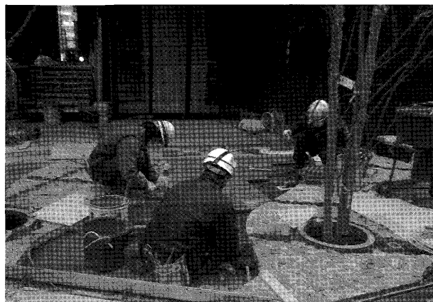
写真-7 「あられこぼし」の曲線にあわせて「瓦と石の小端ユニット」をカットし据え付ける
