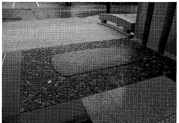
写真－１２ 現場② あられこぼし完成状況
