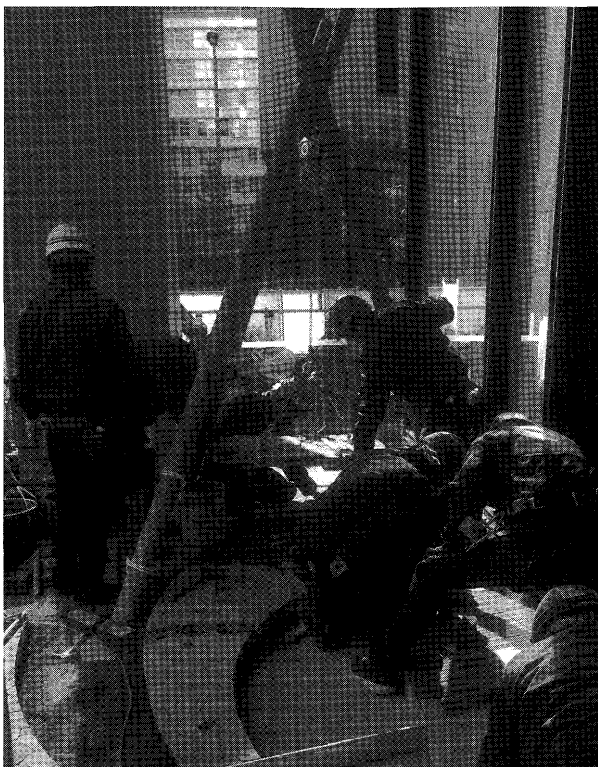
写真-6 クレーンが使えない現場において、三叉を使用してユニットを据え付ける
