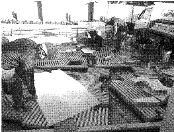
写真－８ 現場② 駐車スペースの施工状況
