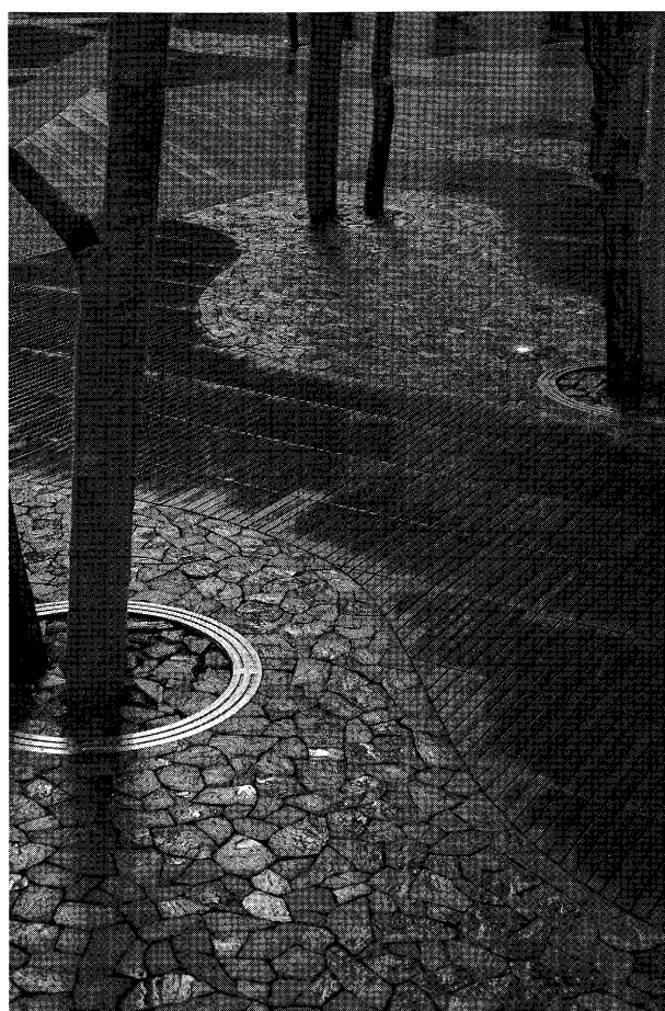
写真－1 「あられこぼしユニット」と「瓦と石の小端ユニット」による舗装
