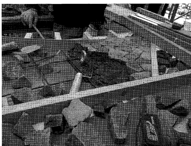
写真-4 ユニット枠への石の据え付け
