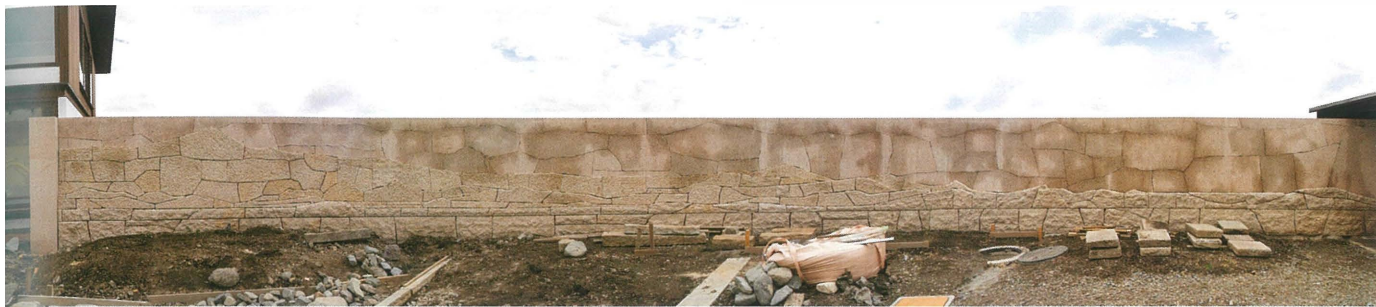
東山石景(施工時) Higashiyama Stonescape (during construction) ( ' 20.09)
