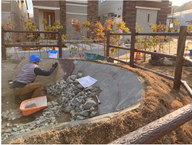
写真-6 施工風景
