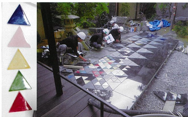
九谷焼タイルとタイル張り施工中 Kutani Porcelain Tiles ( ' 15.09)
