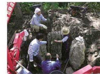
滝石組 施工中*
