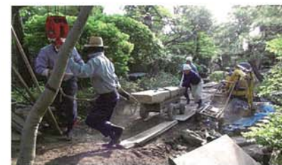
石橋搬入 施工中*
