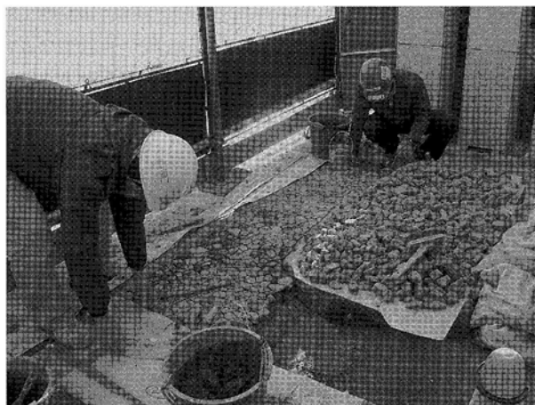
写真-3 嵐山荘 「あられこぼし」ユニットの据付け後に、ユニットとユニットの間（つなぎ部）等を現地施工
